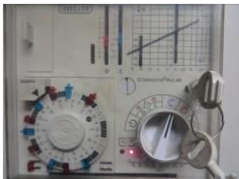
Régulateur analogique avec visualisation direct de la courbe de chauffe
